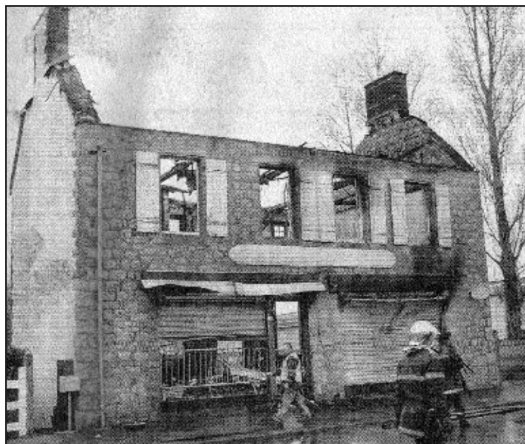
BÉGARD (BRETAGNE), 23 FÉVRIER 2002 : L'étude de l'huissier Me Gaby Eid — 13 rue de Guingamp — est entièrement ravagée par le feu.
